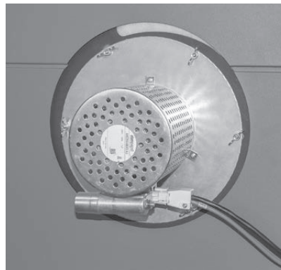
Fig. 72 Gebläse abstecken und abmontieren (Abbildung PuroWIN PW 72–103)
