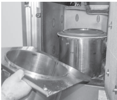
Fig. 65 Flammrohr entfernen und Brennraum reinigen
